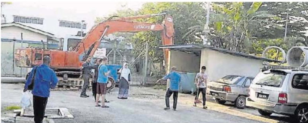
■新成功花园公寓正进行中央排污系统工程, 民众受促注意安全。
